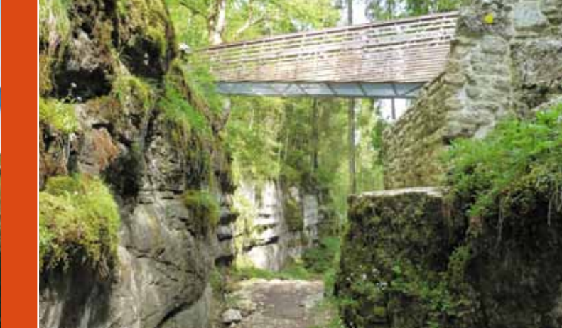
▲ Vestiges restaurés du Pont des Anabaptistes et nouvelle passerelle.
