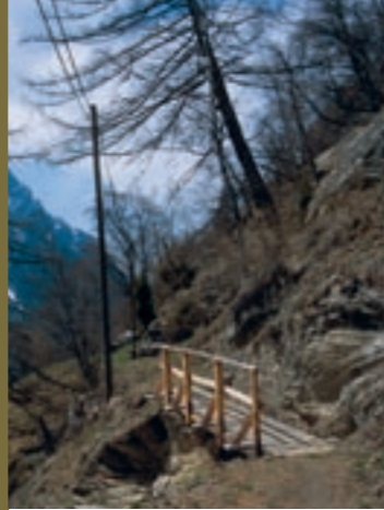
Wegpartien des renovierten Weges im Gantertal
